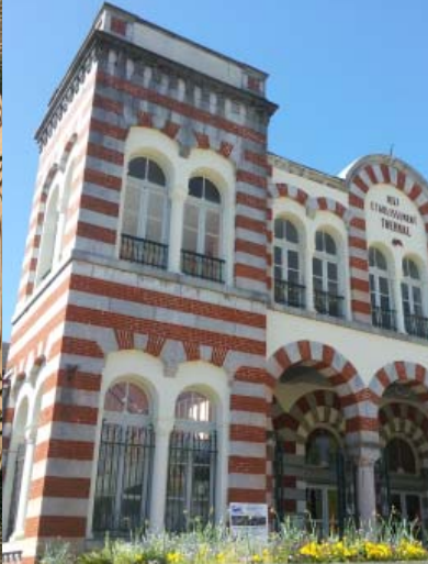
Établissement thermal de Salies-de-Béarn de 1894.
