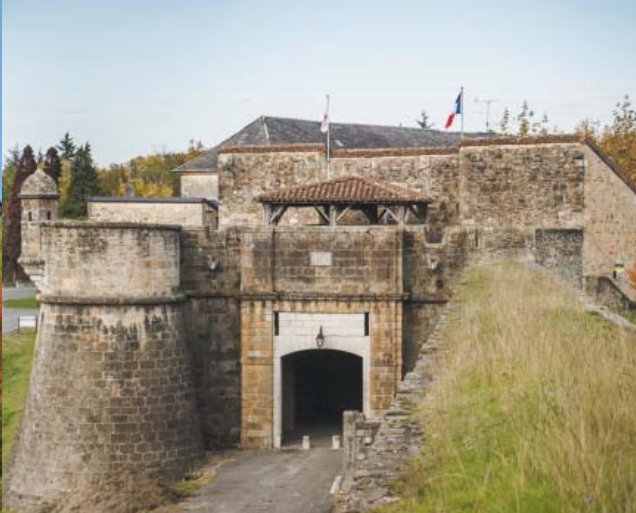
La porte et le bastion Saint-Antoine de Navarrenx (XVI e siècle). © Sébastien Arnouts
