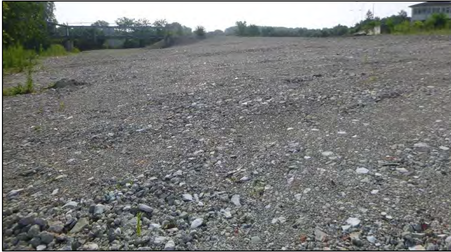
Emplacement des bâtiments détruits ©ETEN Environnement
