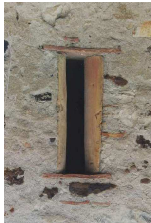
ventilation maçonnée avec deux tuiles
