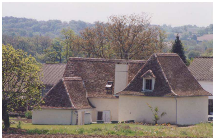
bâtiment secondaire cour bâtiment principal
