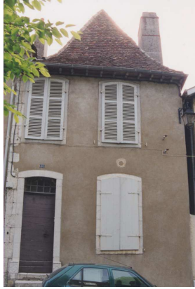
composition sur deux travées – rue Moncade Maisons sur la trame ancienne avec faitage perpendiculaire à la rue, toit en bâtière et croupe sur la rue.
