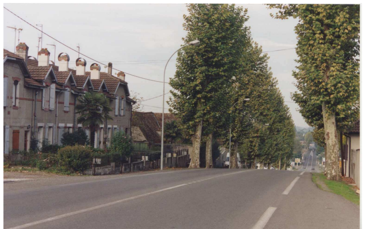
le pavillon d'entrée des usines Lamaignère et les logements de la rue de Pau sont aussi soignés que le reste du domaine.
