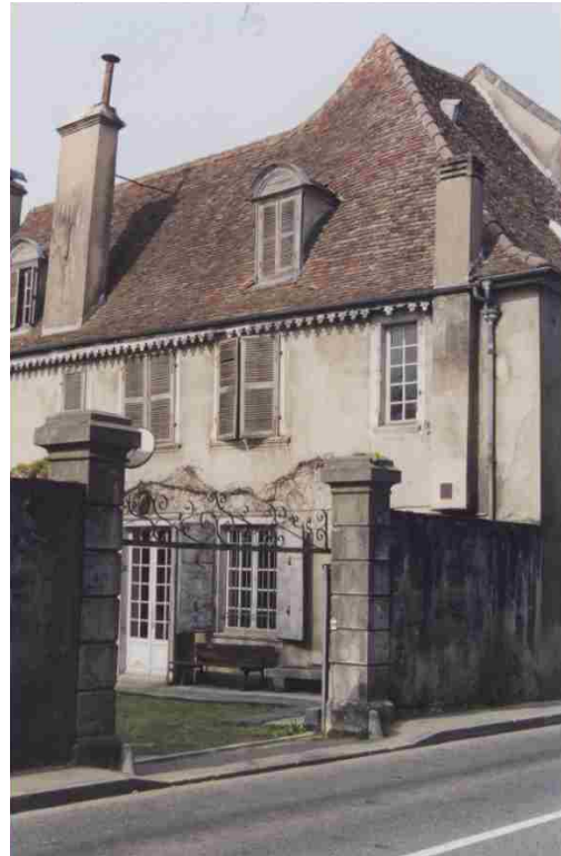
La cour est séparée par un mur maçonneré équipé d'un portail
