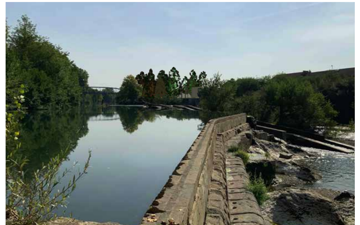
Projet Depuis la centrale
