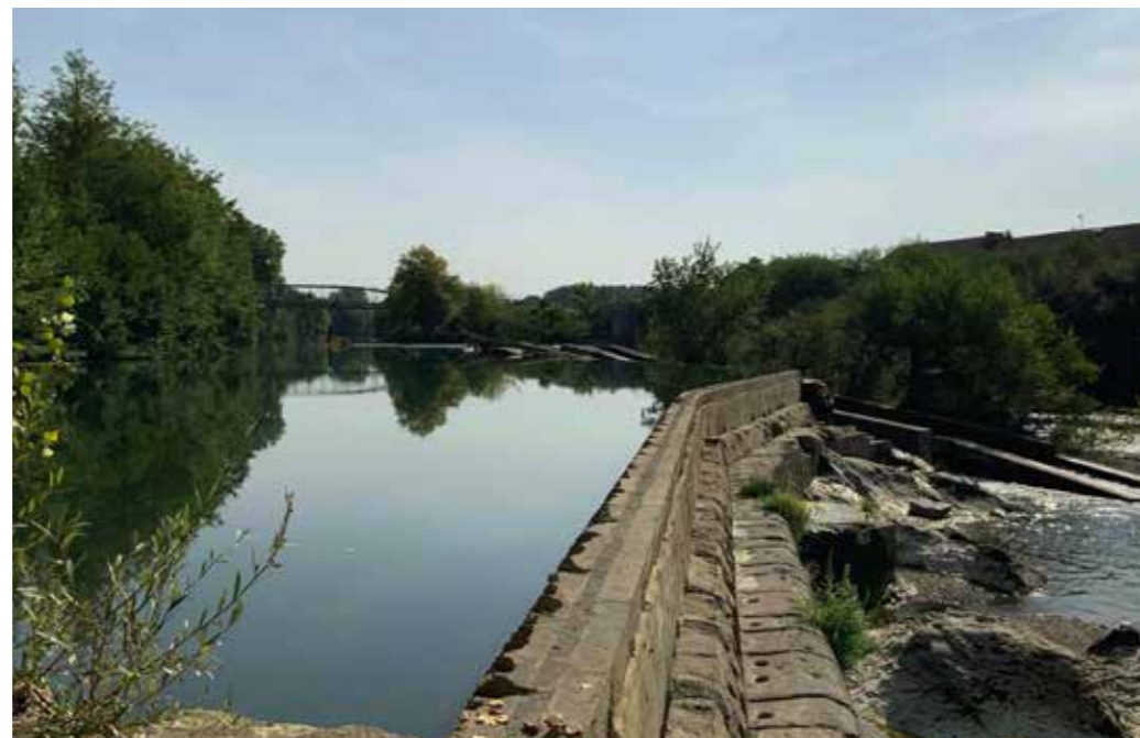
Existant Depuis la centrale
