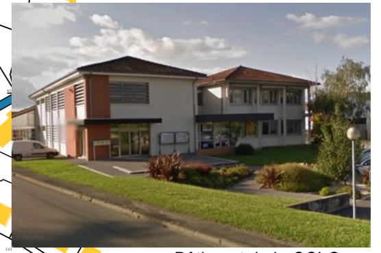
Bâtiment de la CCLO
