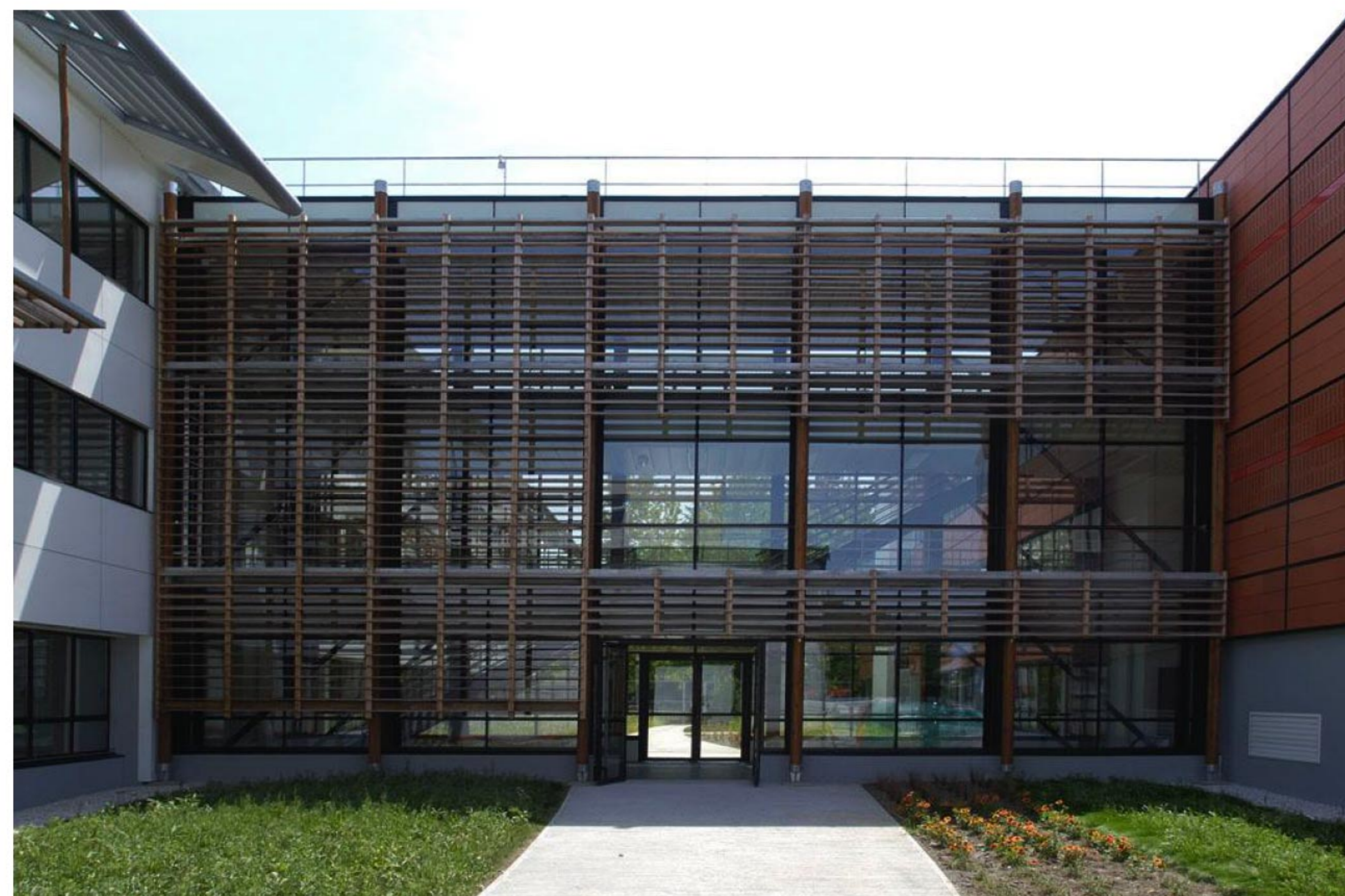
Traitement des façades différencié : au Sud, la façade blanche renvoie la lumière sur la façade nord.
