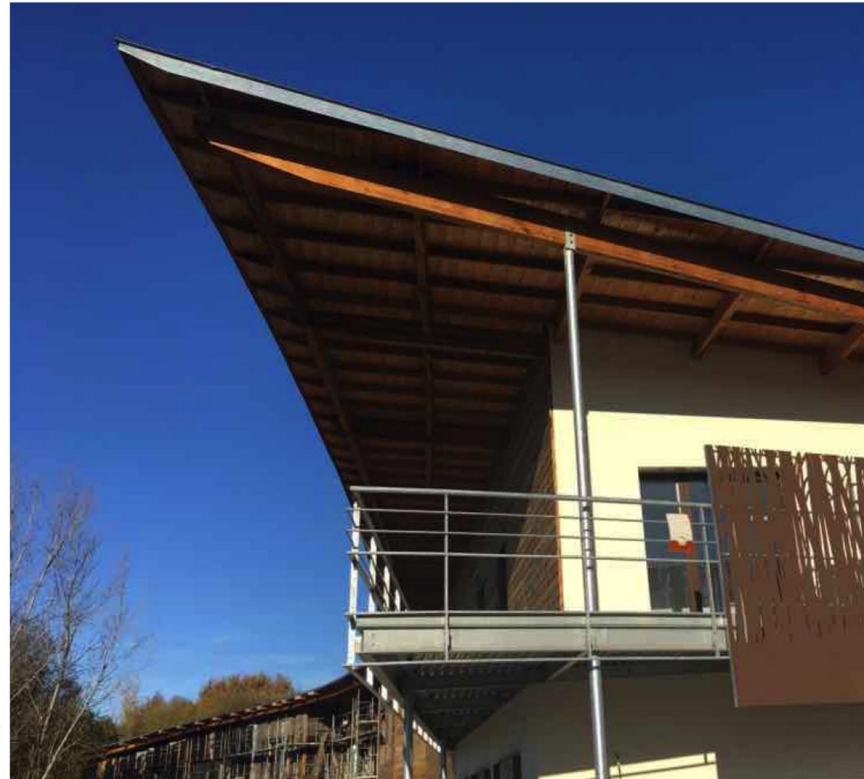
Les terrasses et les débords de toit participent à la gestion de l'ensoleillement.
