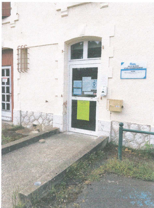
Service de la Régie de l'Eau et de l'Assainissement, sis 10 bis avenue Francis Jammes à Orthez Sainte Suzanne
