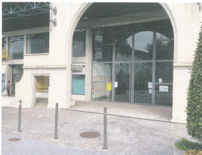
Complexe de la Moutète, sis Place de la Moutète à Orthez Sainte-Suzanne
