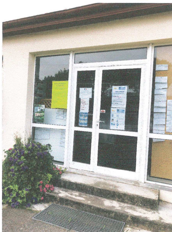
Service Urbanisme de la ville d'Orthez, sis 10 bis avenue Francis Jammes à Orthez Sainte-Suzanne
