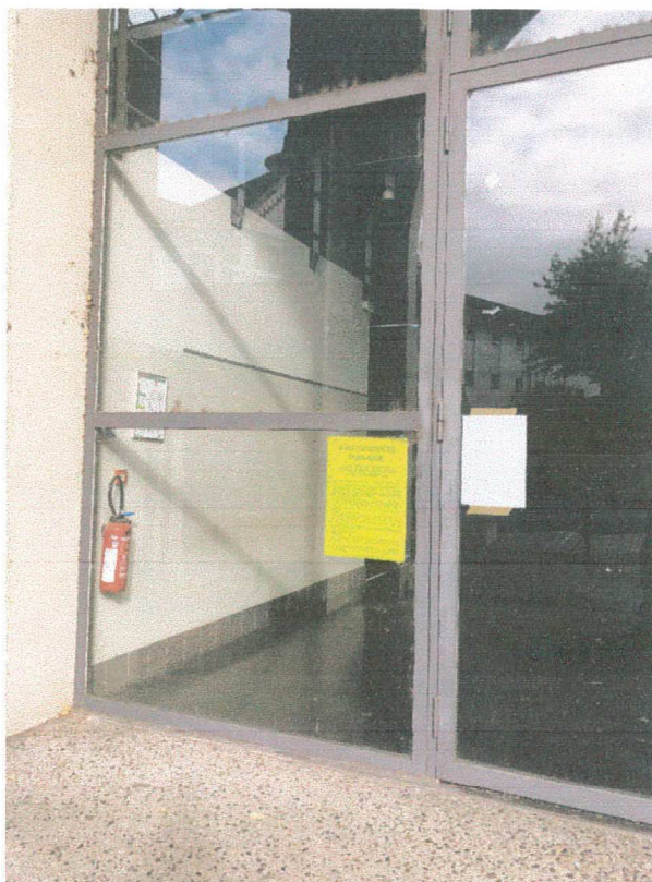
Complexe de la Moutète, sis Place de la Moutète à Orthez Sainte-Suzanne
