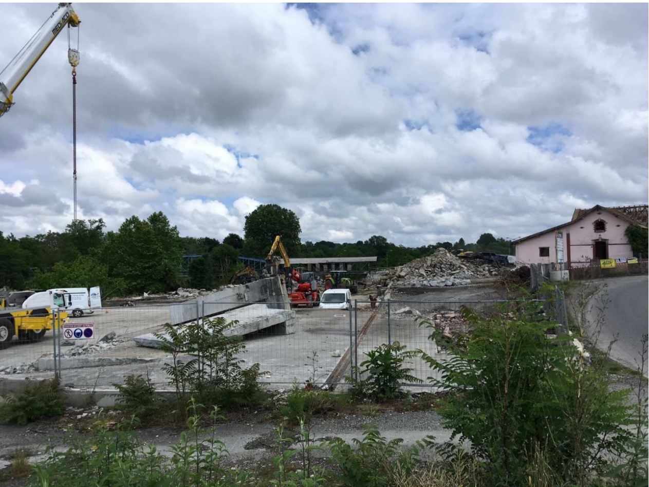
Vue depuis l'avenue du Pesqué
